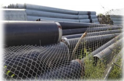
Construcción de Tubería Vía Verde
